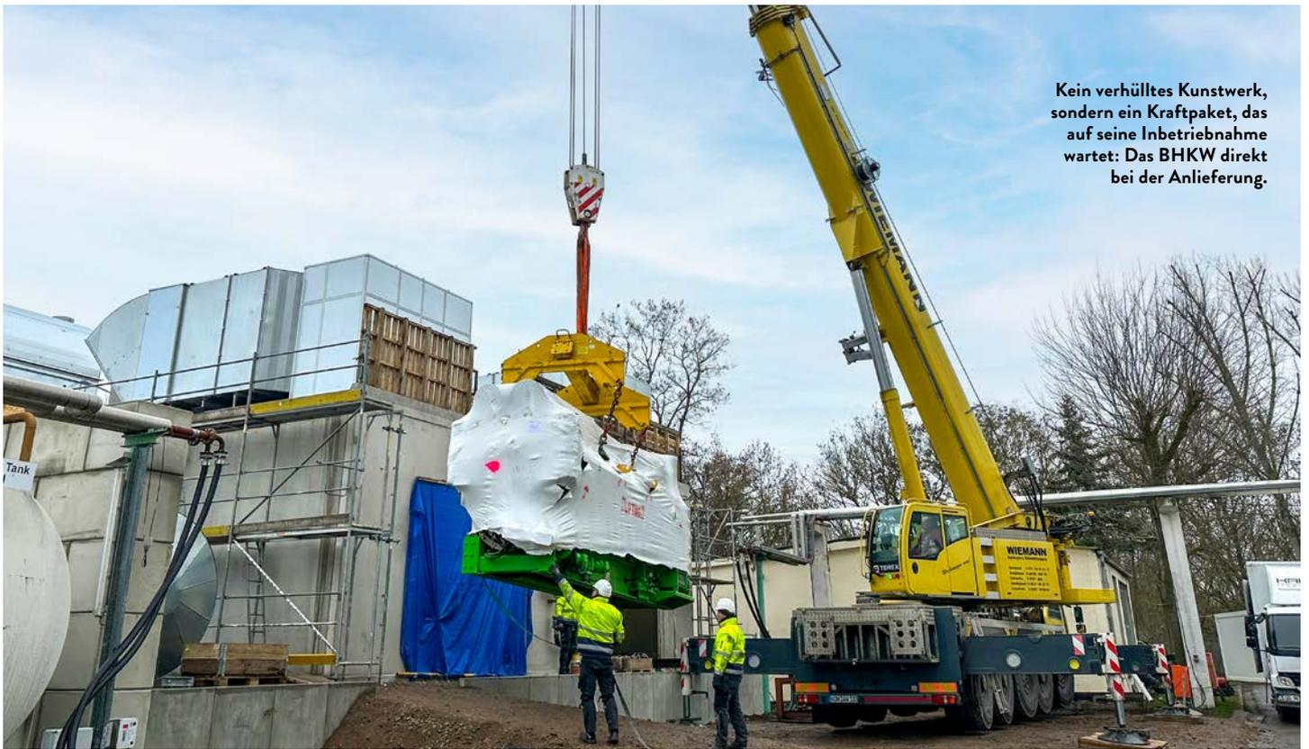
Kein verhülltes Kunstwerk, sondern ein Kraftpaket, das auf seine Inbetriebnahme wartet: Das BHKW direkt bei der Anlieferung.
