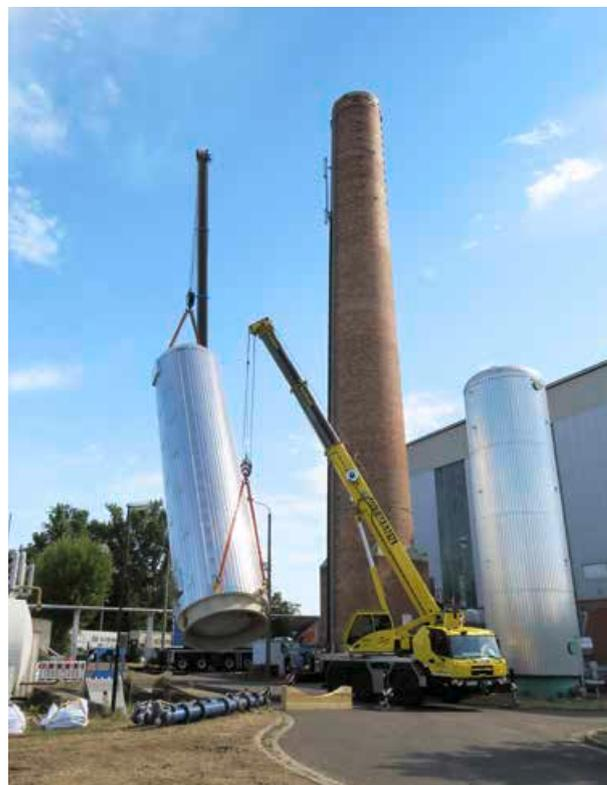
Links neben dem Schornstein des Kraftwerks wurde ein neuer, ca. 20 Meter hoher Wärmespeicher installiert.
