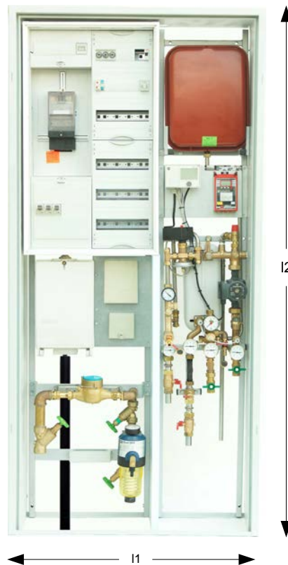
Abbildung 4: Darstellung einer Hausanschlussnische
